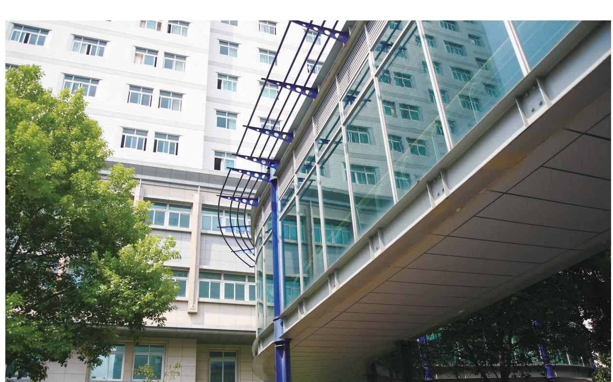
妇儿楼—外科楼：2002—03年建设，长52米，宽3.7米，总高度9米，建筑面积约192平方米。主要承重结构采用耐候钢并进行防锈处理，内饰吊顶采用金属格栅吊顶，地面为橡塑防滑地板密拼。
