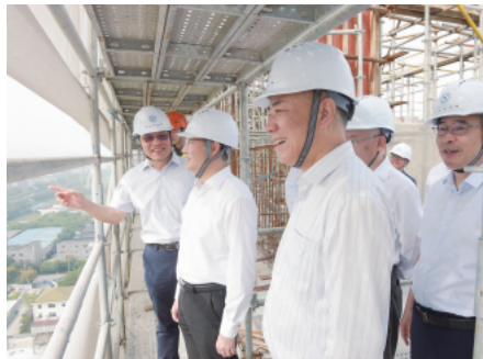
各位领导考察建设中的新华医院奉贤院区
